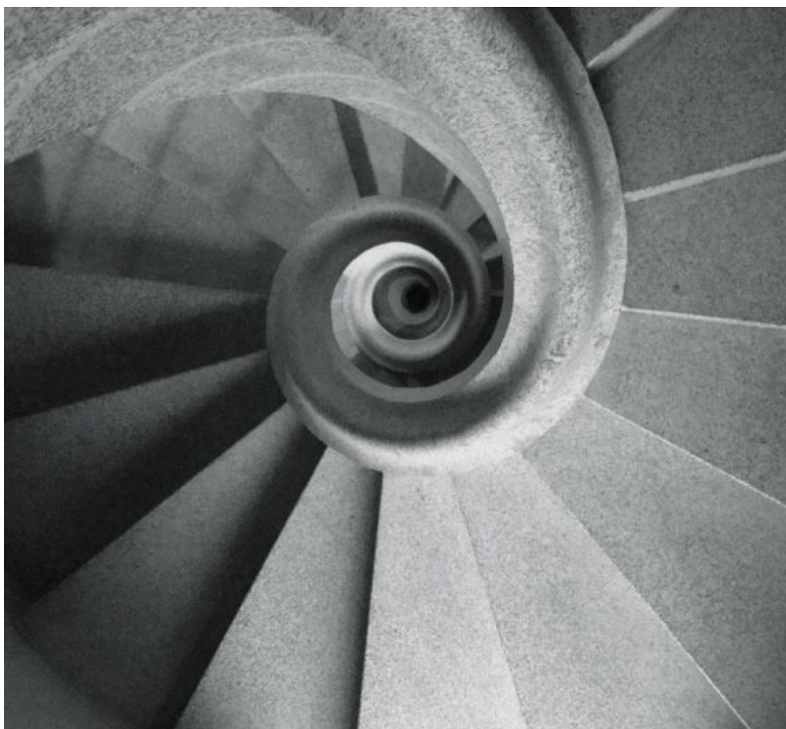
Una de las sorpresas de la Sagrada Familia y que se repite en parte de su obra: las poéticas escaleras que provocan vértigo
